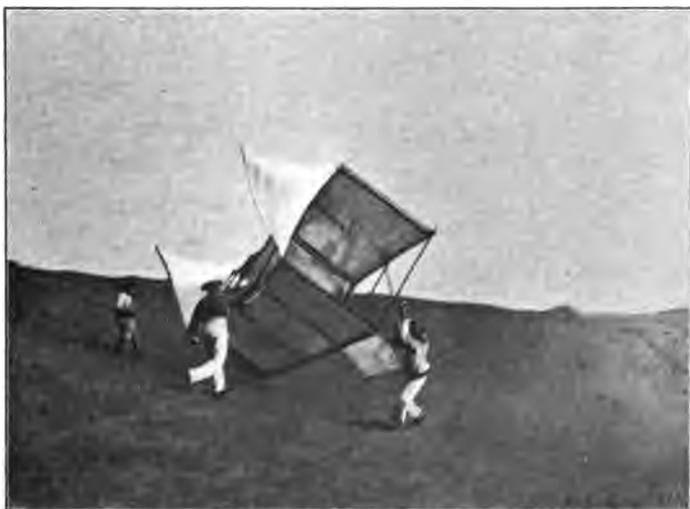
Fig. 43. — 2<sup>e</sup> essai. — On se place trop en avant et on tombe sur le nez.
